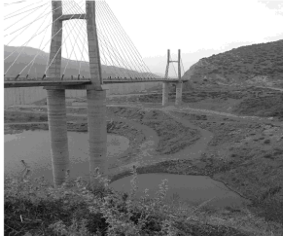
Figure 1. Vue générale du pont à haubans sur l'Oued Dib à Mila.
