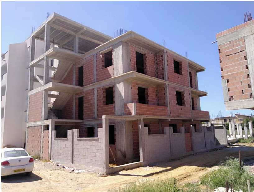
Photo : Carcasse d'une maison. Reghaia (Alger).
