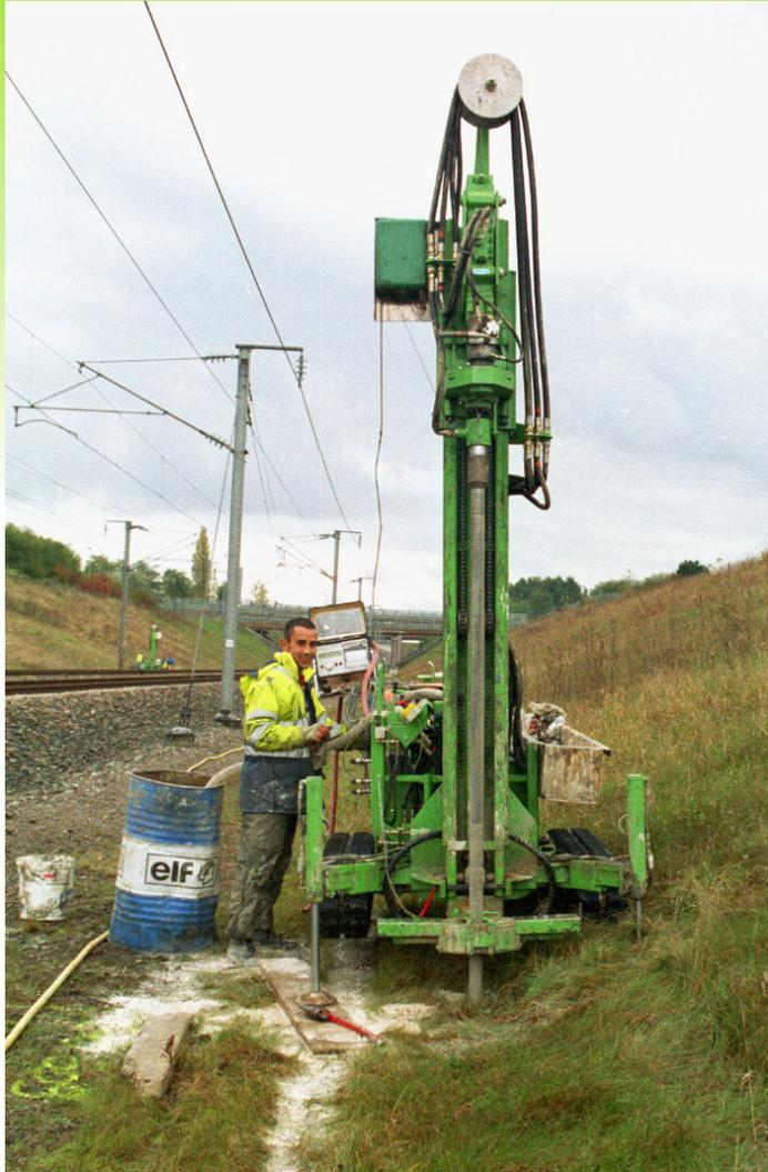
Les sondages destructifs désagrègent le sol, même dur, les débris ou cuttings étant remontés vers la surface par un fluide (eau, boue); on distingue :
