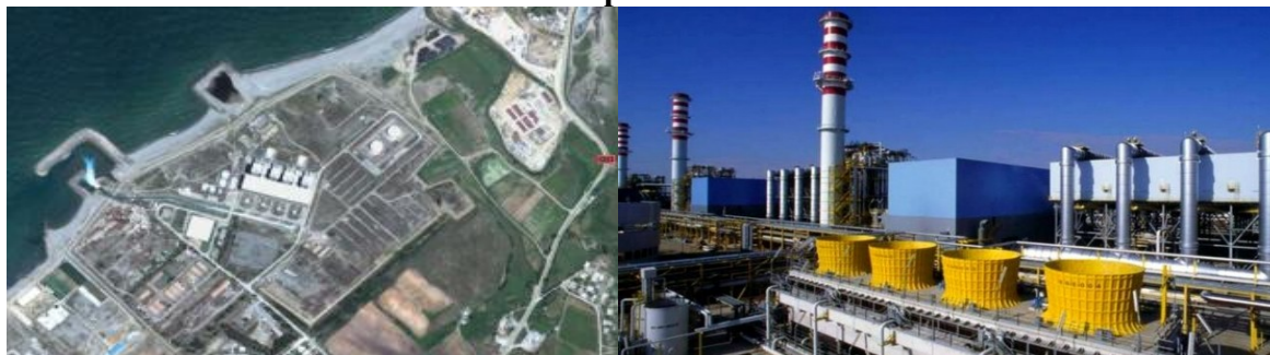
Site de la Centrale électrique d'El Tarf
