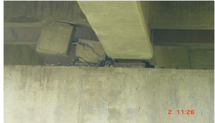
*Endommagement des butées sismiques sous l'effet du mouvement transversal du tablier*
