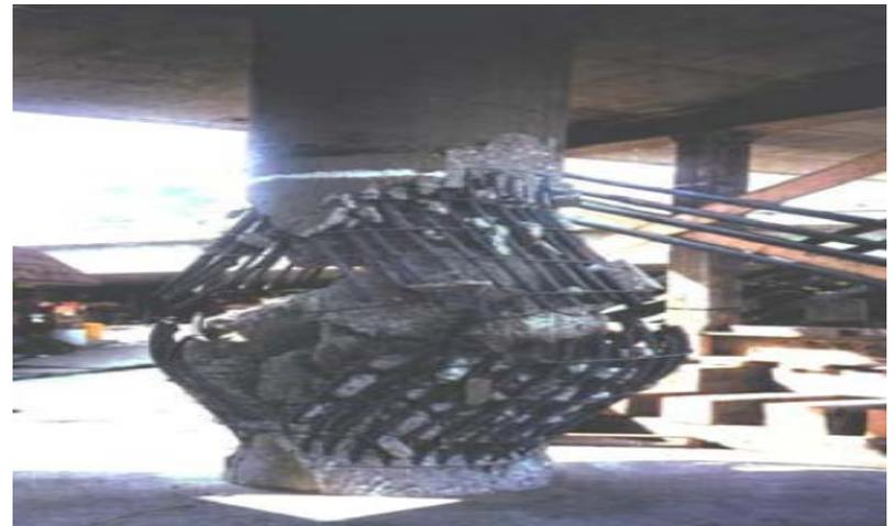
*Rupture des piles par flambement des armatures longitudinales (Northridge, 1994)*
