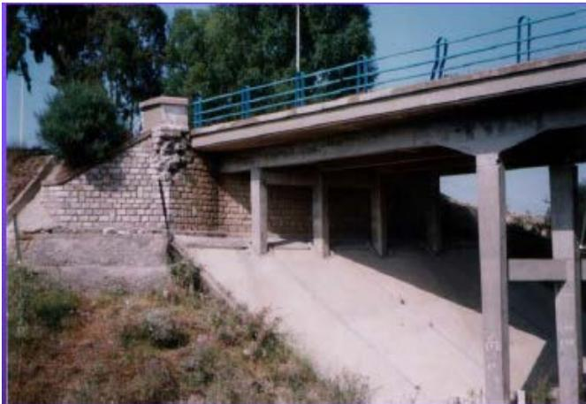
*Déstabilisation de la maçonnerie de la culée*
