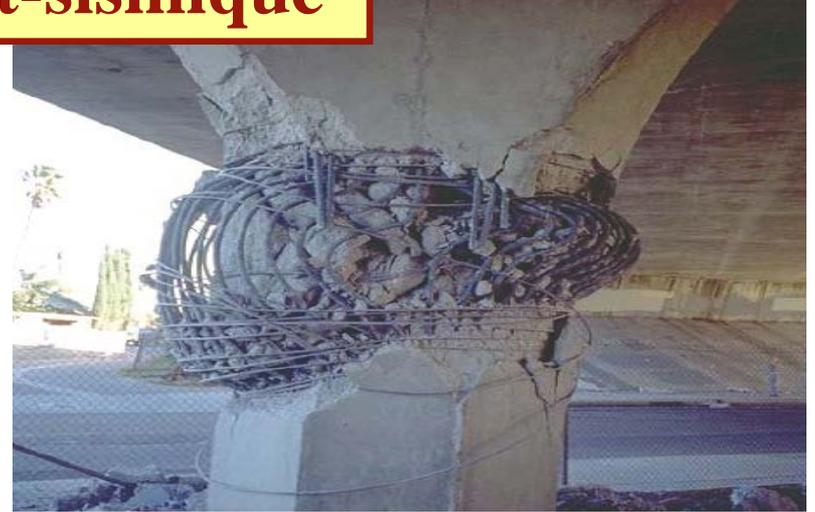
*Rupture par manque de confinement d'une pile de pont en béton armé (Northridge, 1994)*
