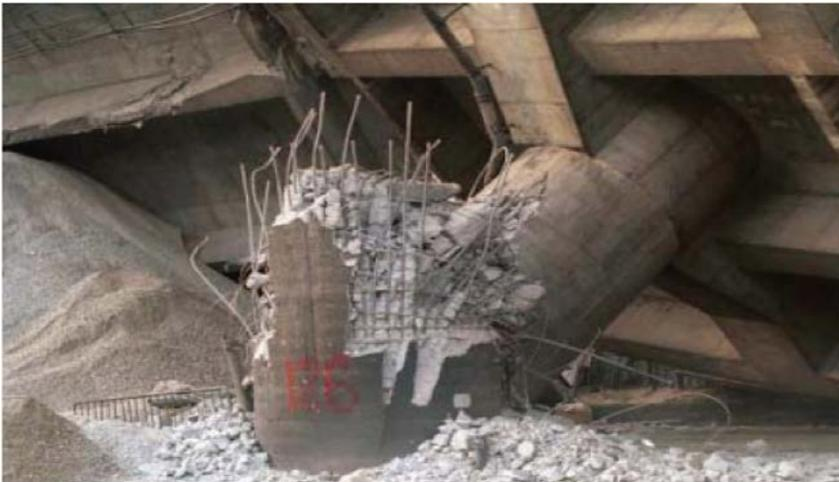
*Rupture des piles par cisaillement et effondrement du tablier (Kobe, 1995)*
