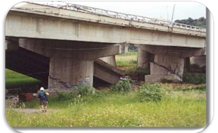
*Rupture due à l'effort tranchant des piles de pont (séisme
